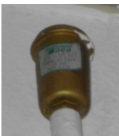
Bild: „Übung Filmleiste – Ausgleichsgefäß mit Überdruckventil“, Michaelis für SenBJW Berlin, CC BY 3.0 de
