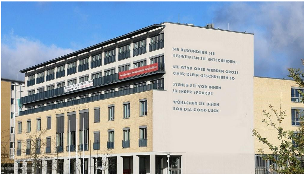
Die Neugestaltung der Fassade der ASH
